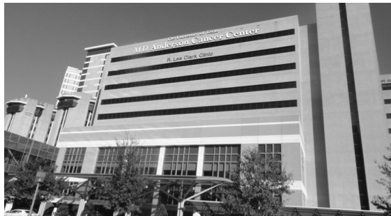
写真1 M. D. アンダーソン癌センターのメインビル
